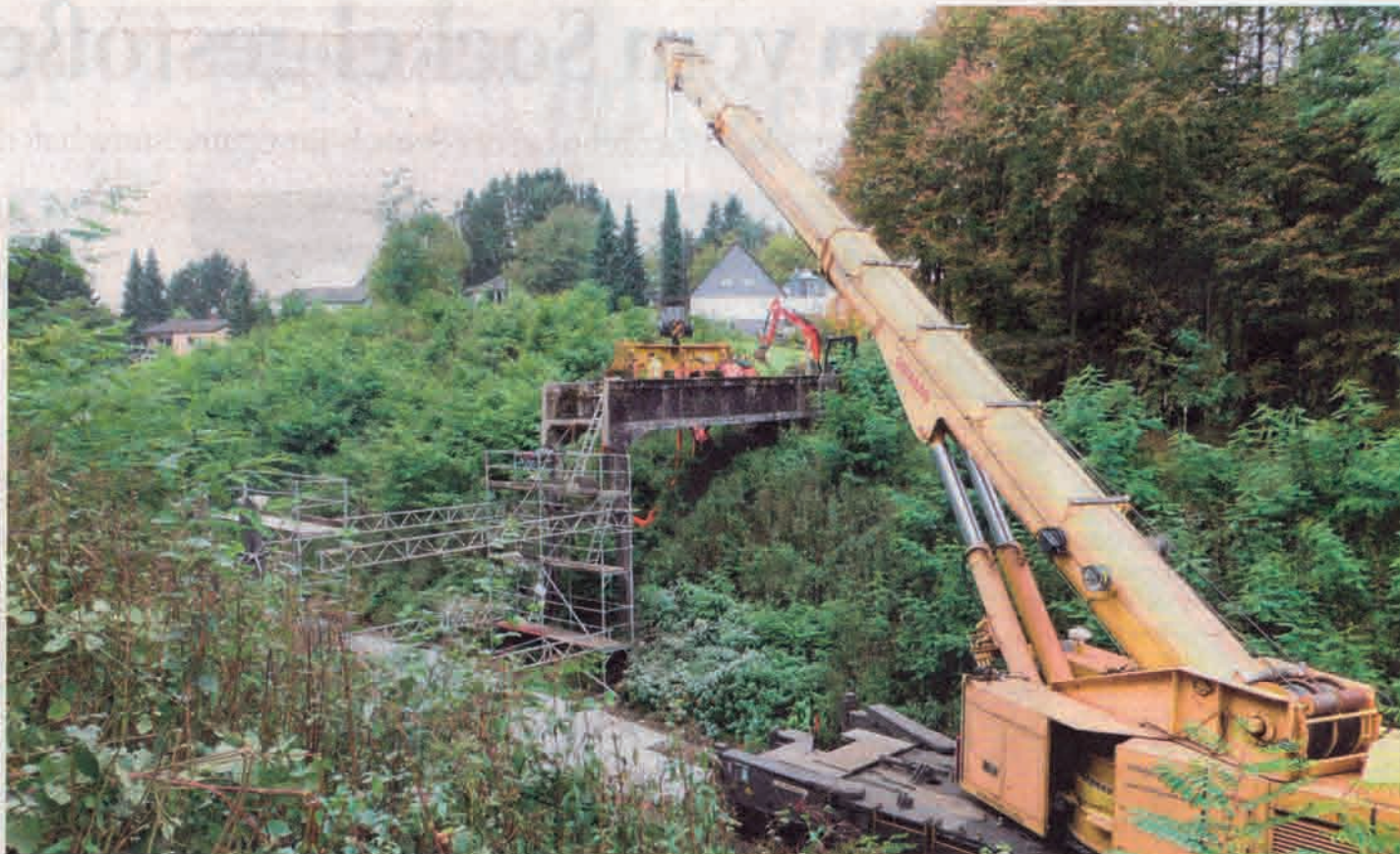
In drei Teile zersägt und an den Haken genommen wurde die Brücke über der am Wochenende gesperrten Bahnstrecke Köln-Gummersbach.
